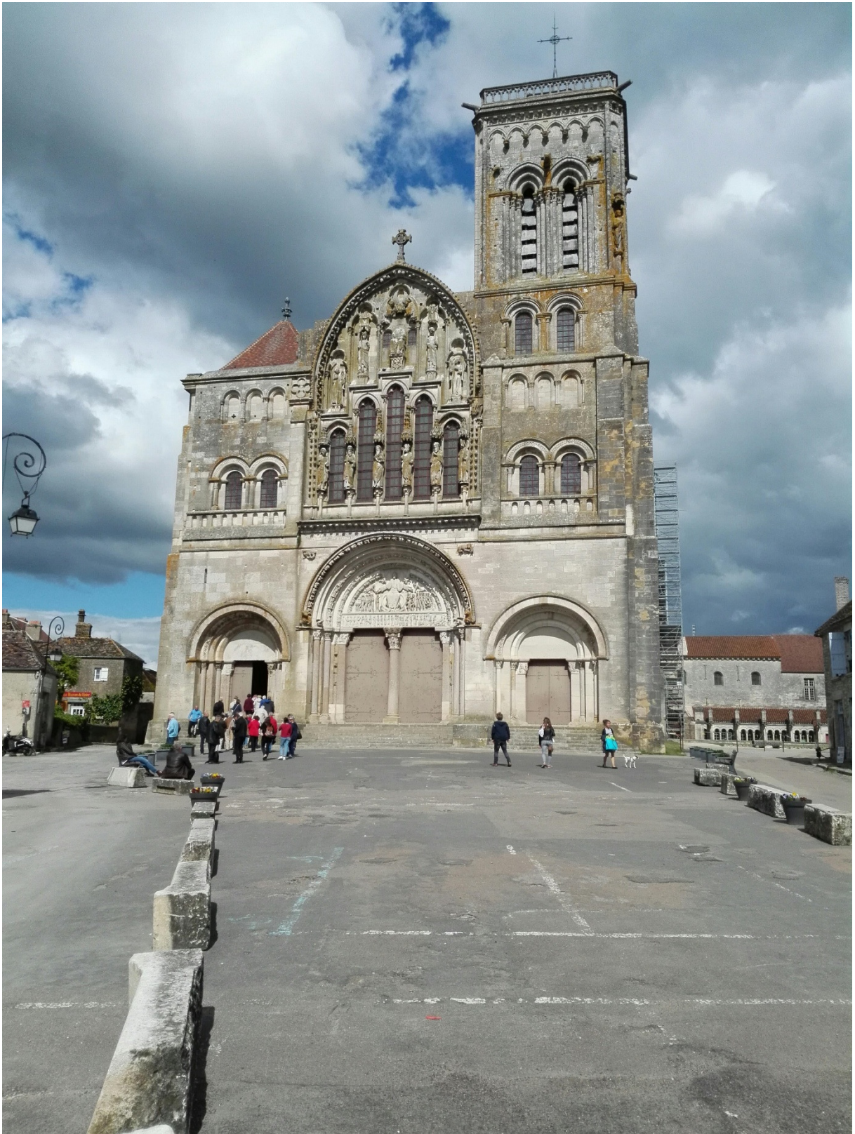
Die Hauptfassade der Basilika St. Madeleine von Vézelay
